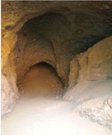
Canal interno de la montaña para conducir el agua
